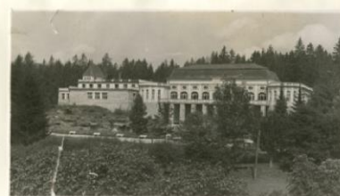
Najkrajšia kúpeľná budova „Restaurácia“
